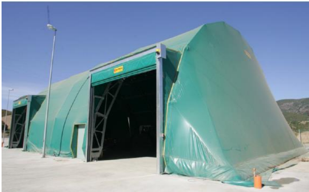
Capannone di ricezione
