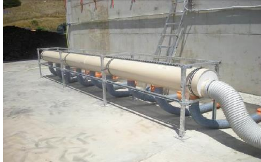
Gruppo di ventilazione biocella per la fase ACT e per la fase di CURING
